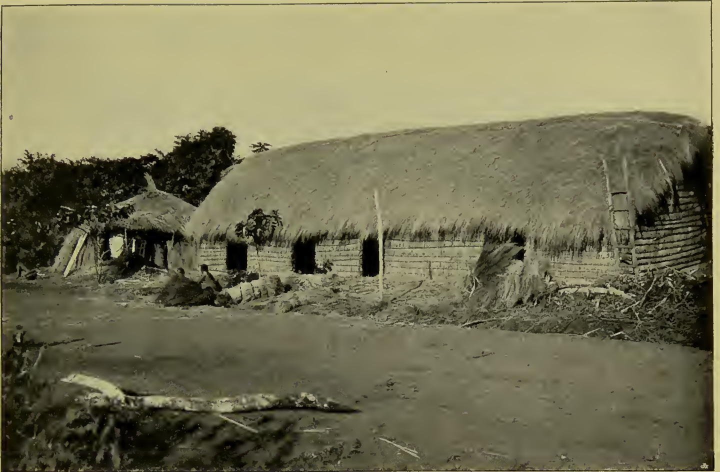
Fig. 80. Baracke im Bau.
